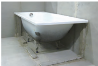
STEP 2. 余った部材をバックアップとして使用し、ボードを接着固定
