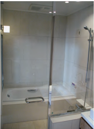
カルデバイのバスタブをシステムバスに組み込み、施工した事例
