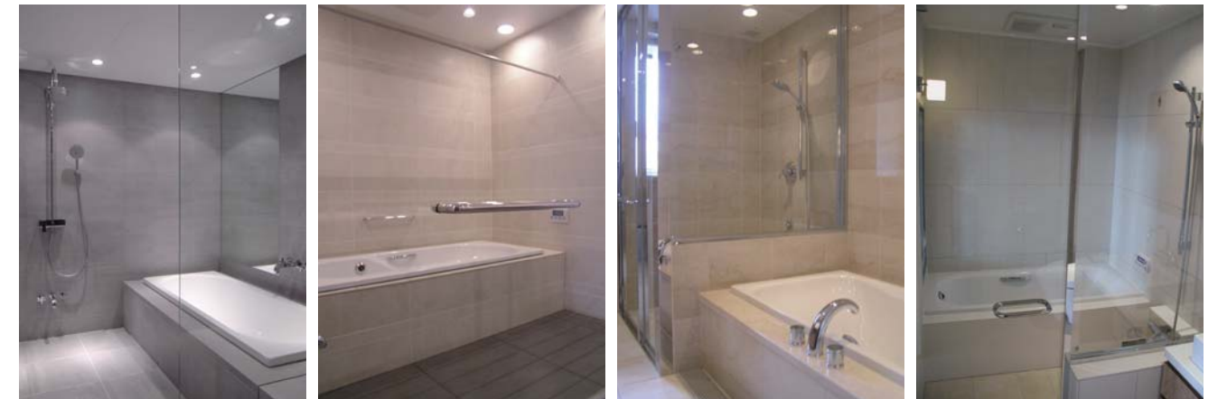
カルデパイのバスタブをシステムバスに組み込み、施工した事例
